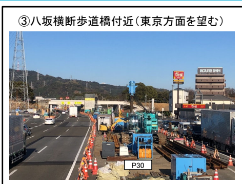
P30橋脚の鋼矢板打設中
