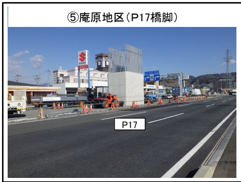
P17橋脚のコンクリート柱施工完了
