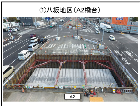
A2橋台底版のコンクリート打設完了
