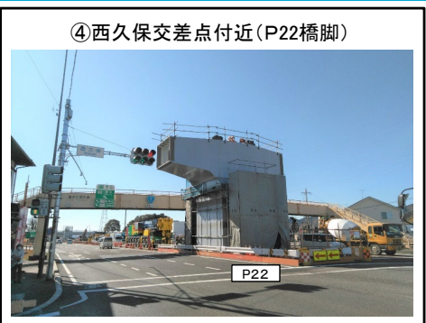
P22橋脚の鋼製橋脚(柱頭部)架設完了
