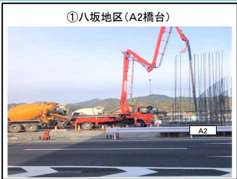
A2橋台のコンクリート打設状況
