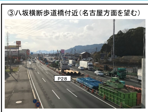
P28橋脚の場所打ち杭施工状況
