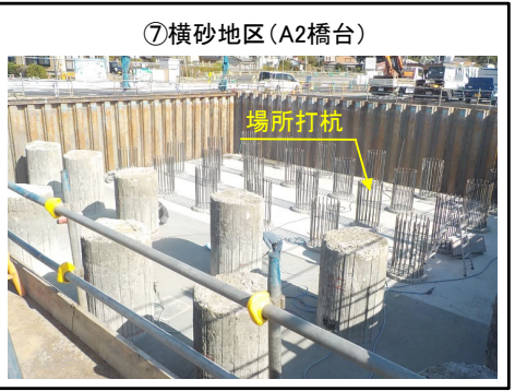
A2橋台の場所打杭施工状況(杭頭処理)
