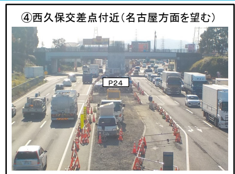
P24橋脚の仮設工施工状況
