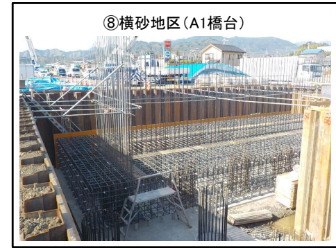
A1橋台の底版施工状況
