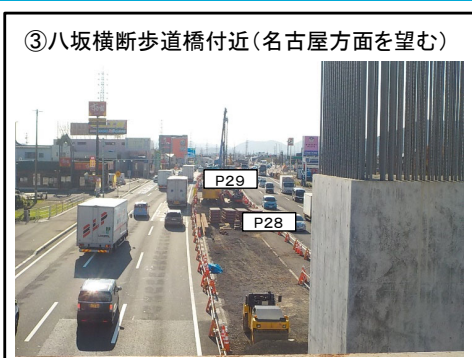
P28橋脚の仮設工施工状況 P29橋脚のRC橋脚工施工状況
