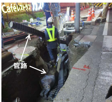
管路部施工状況
