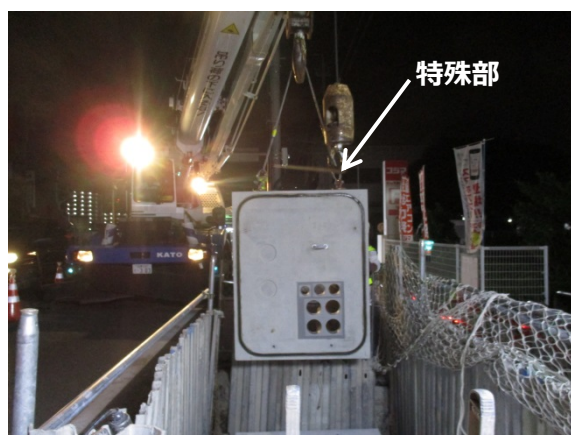
特殊部施工状況
