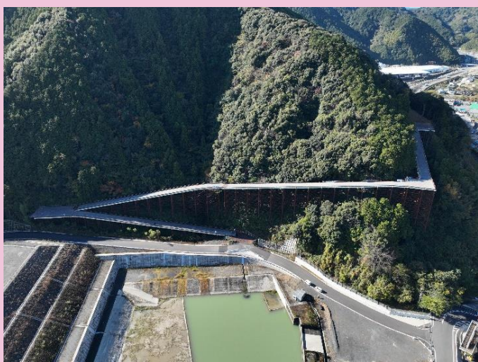
仮栈橋 設置状況（令和7年4月現在）
