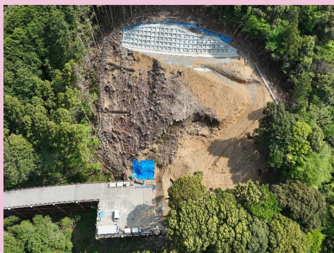
のり面对策箇所 施工状況（令和7年4月現在）
