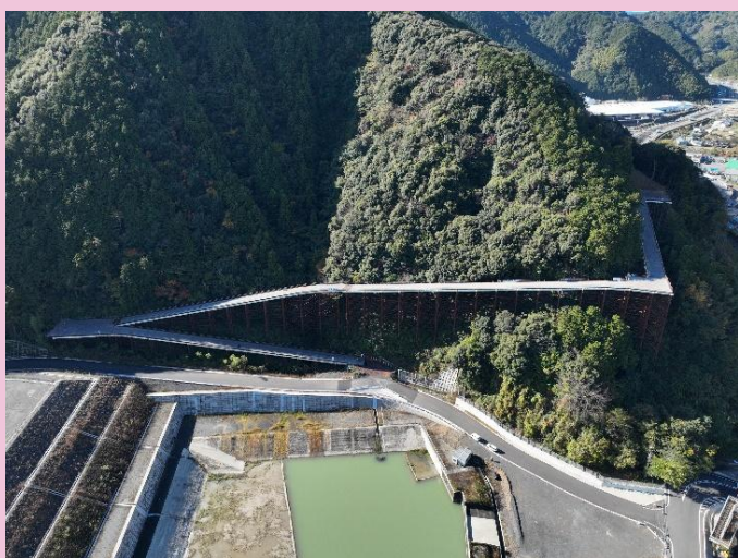
仮栈橋 設置状況
