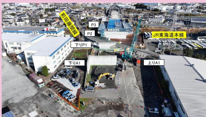
橋梁下部工事 施工状況
