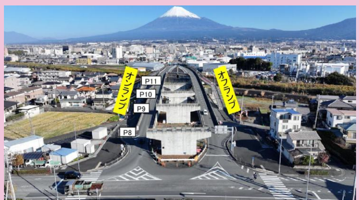
橋梁上部工事 施工状況
