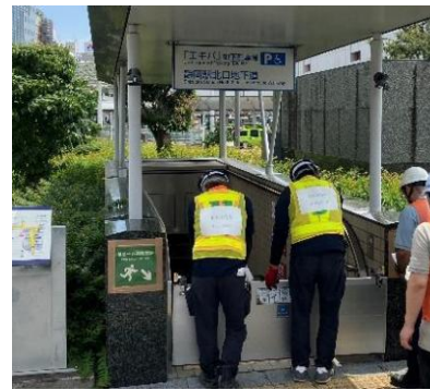
車両用及び歩行者用出入口にて、止水板を正常に設置できるかを確認
