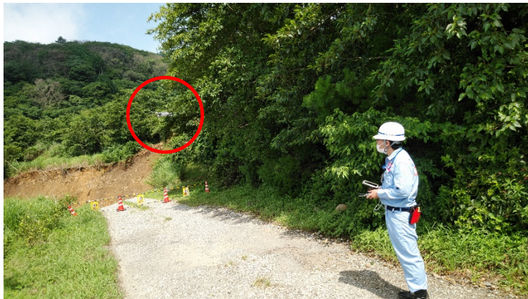
被災箇所源頭部のドローン調査
