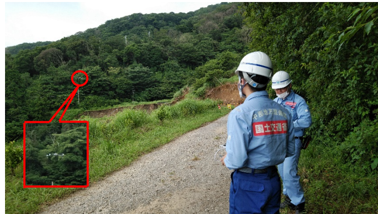
被災箇所のドローン調査
