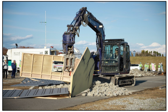
解体工事業協会による倒壊家屋撤去
