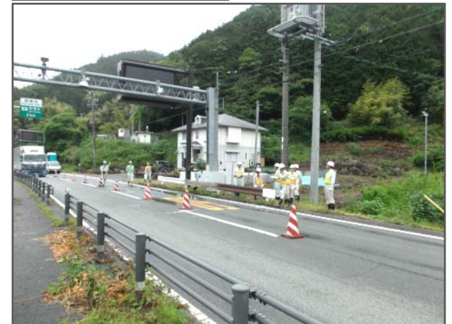
③ 遮断機訓練（全景）
