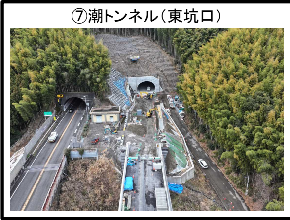
⑦潮トンネル(東坑口) 舗装工 施工中 道路付属施設工 施工中 排水構造物工 施工完了
