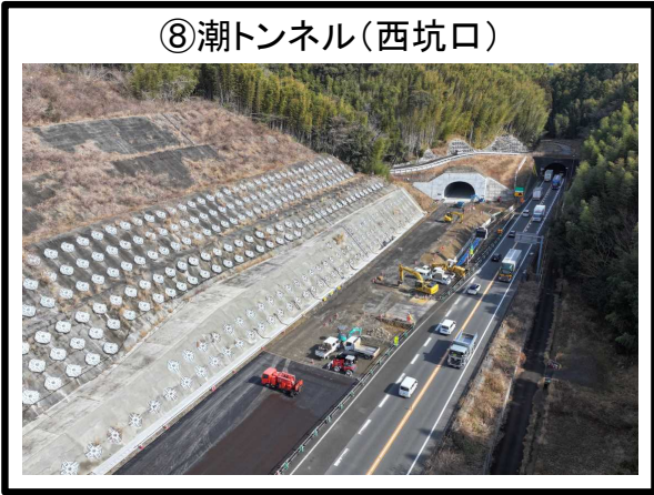
⑧潮トンネル(西坑口) 舗装工 施工中 道路付属施設工 施工中 排水構造物工 施工完了
