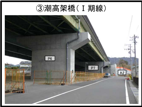
③潮高架橋(Ⅰ期線) P6・P7・A2橋台 拡幅 施工完了
