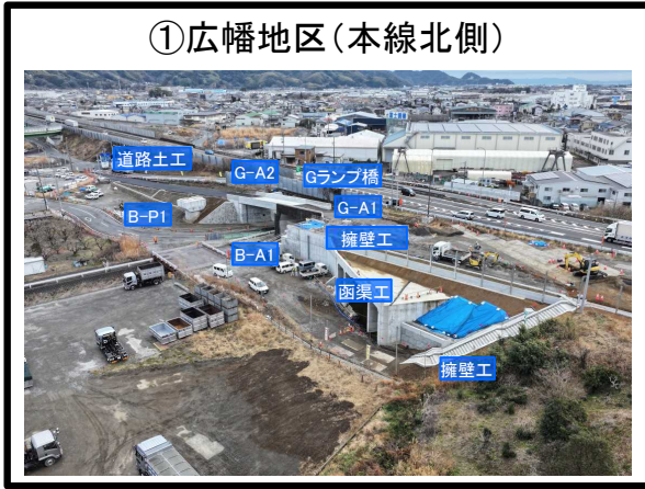
①広幡地区(本線北側) 舗装工 施工中 排水構造物工 施工完了 擁壁工 施工完了 遮音壁工 施工中
