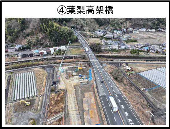
④葉梨高架橋 橋梁下部工 施工中
