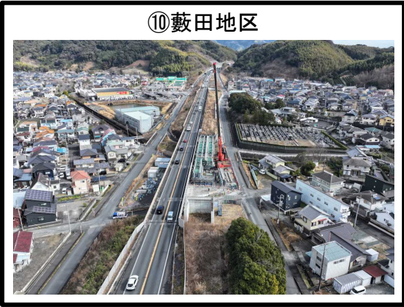
⑩藪田地区 擁壁工 施工完了
