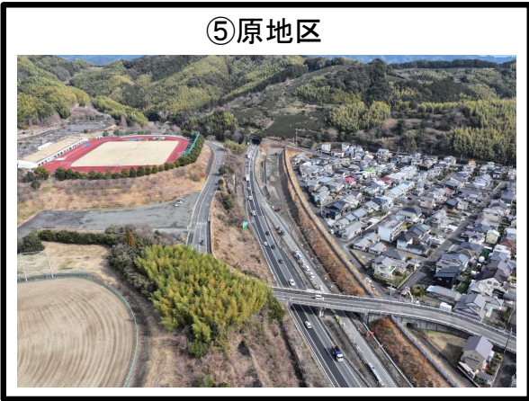
⑤原地区 道路土工、舗装工 施工中
