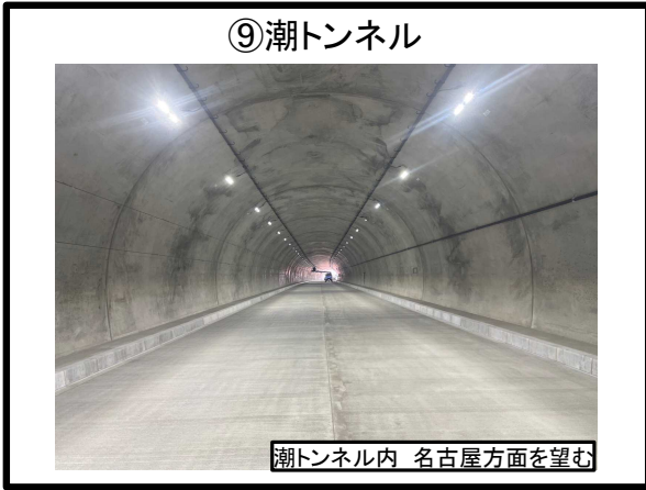
⑨潮トンネル 排水構造物工 施工完了 配電線設備工 施工完了 舗装工 施工完了 トンネル設備工 施工完了
