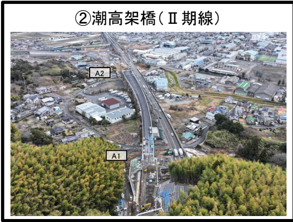
②潮高架橋(Ⅱ期線) A1橋台～A2橋台 舗装工 施工中 遮音壁工 施工完了
