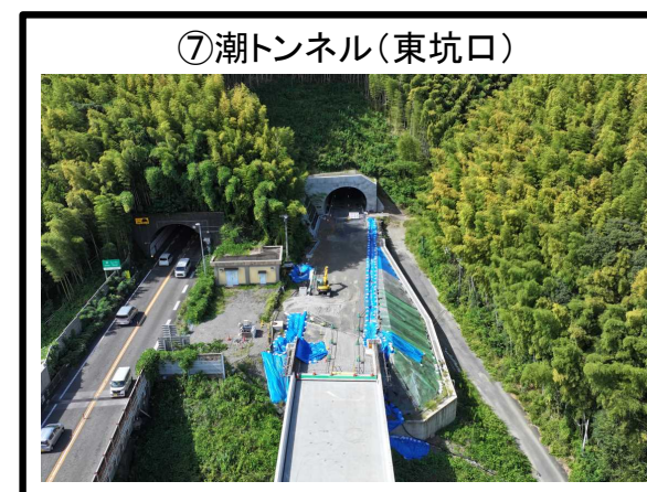
⑦潮トンネル (東坑口) 路床工 施工完了
