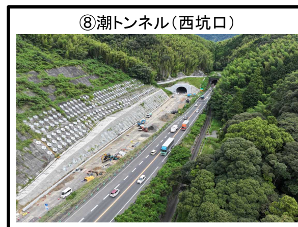
⑧潮トンネル (西坑口) 排水構造物工 施工中
