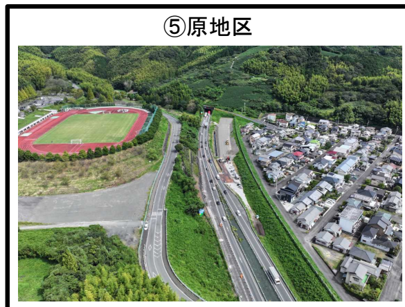
⑤原地区 道路土工、舗装工 施工中
