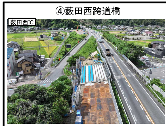
④藪田西跨道橋 橋梁上部工 施工中
