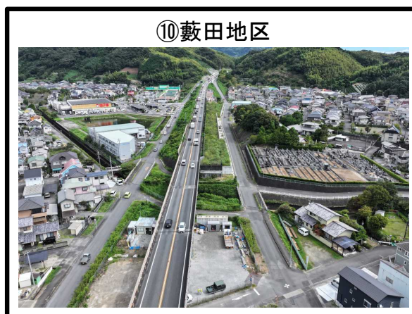
⑩藪田地区 擁壁工 施工完了
