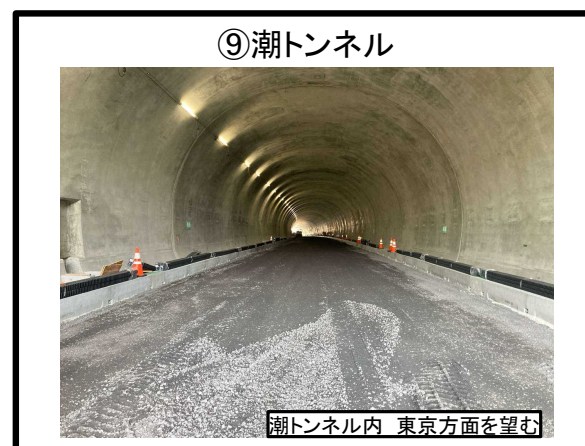
⑨潮トンネル 排水構造物 施工完了 配電線設備工 施工中 舗装工 施工中
