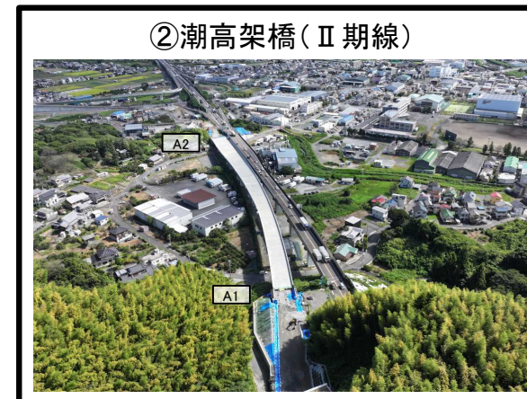
②潮高架橋 (II期線) A1橋台～A2橋台 舗装工 施工中
