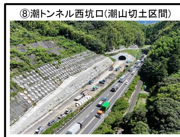
坑門工 施工完了 排水構造物工 施工中
