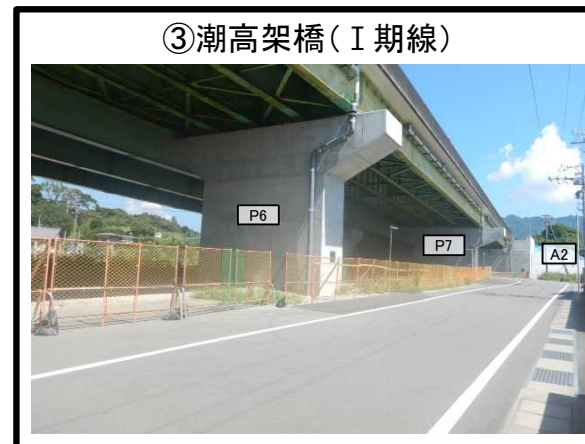
P6・P7・A2橋台 拡幅 施工完了
