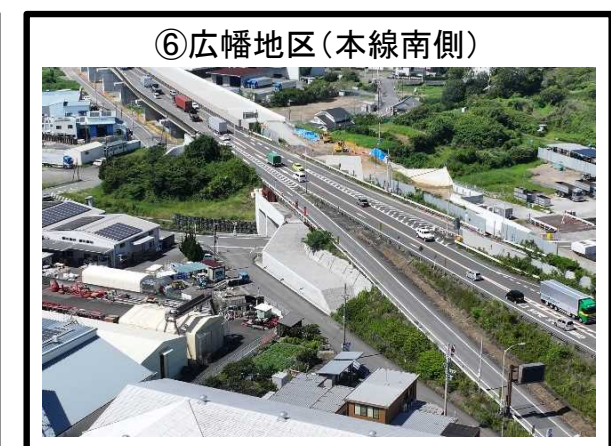
擁壁工 施工完了
