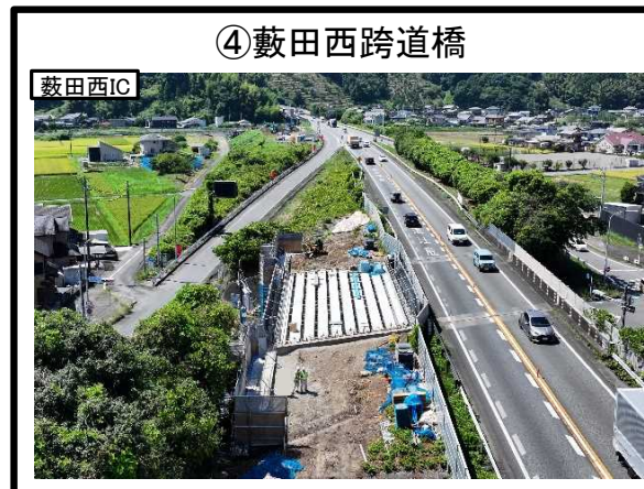
橋梁上部工 施工中
