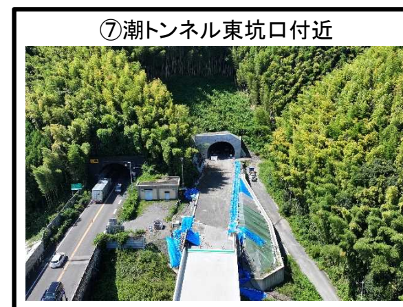
路床工 施工完了 坑門工 施工完了
