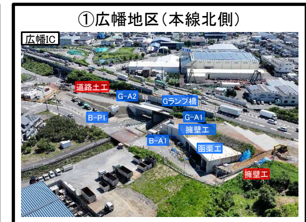
橋梁上部工(Gランプ橋) 施工完了 擁壁工 施工中
