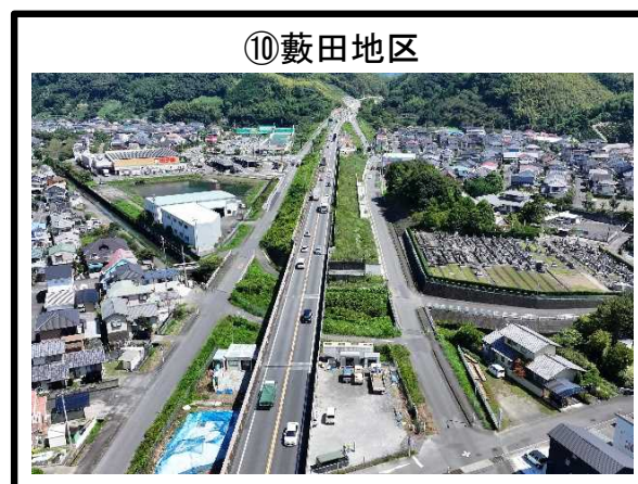
擁壁工 施工完了
