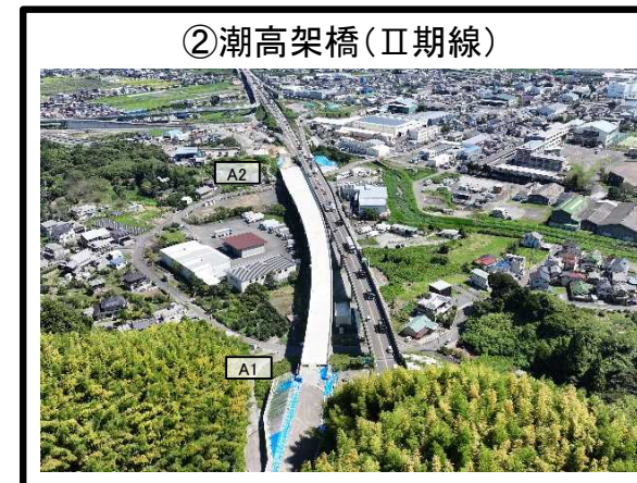
A1橋台～A2橋台 上部工 施工完了
