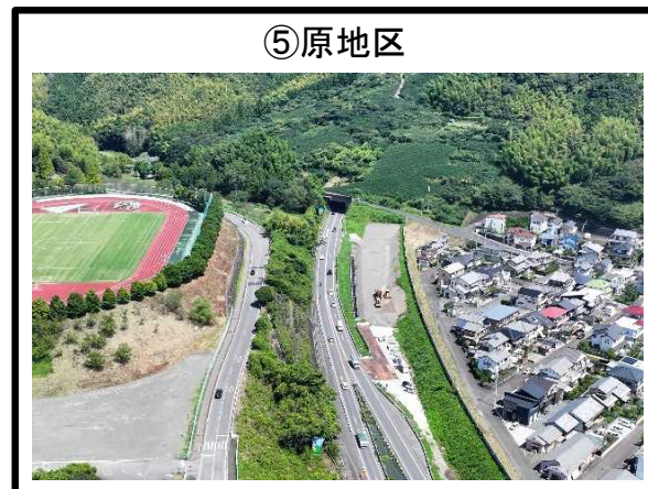
準備工 施工中
