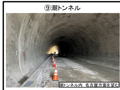
⑨潮トンネル トンネル覆工 施工完了
