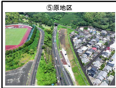
⑤原地区 準備工 施工中
