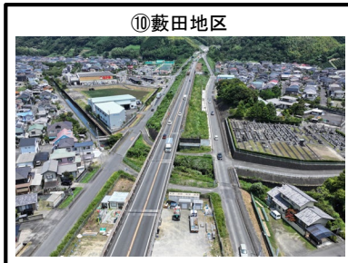
⑩薮田地区 擁壁工 施工完了
