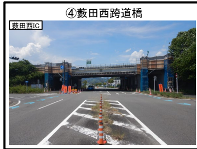
④薮田西跨道橋 橋梁上部工 施工中
