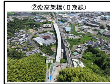
②潮高架橋 (II 期線) A1橋台～A2橋台 上部工 施工完了
