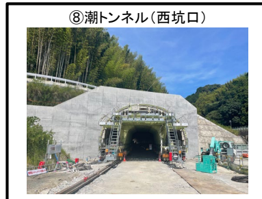
⑧潮トンネル (西坑口) 坑門工 施工完了
