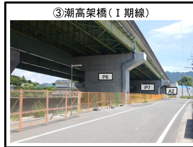
③潮高架橋 (I 期線) P6・P7・A2橋台 拡幅 施工完了
