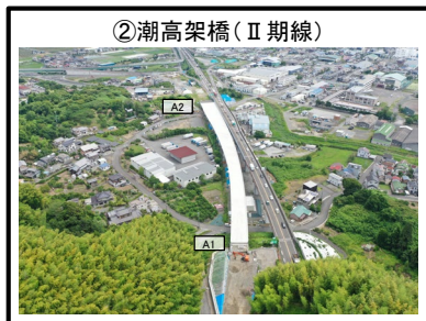
②潮高架橋 (II期線) A1橋台～A2橋台 上部工 施工完了
