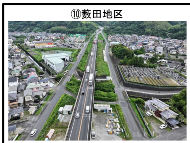
⑩藪田地区 擁壁工 施工完了
