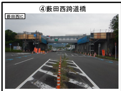
④藪田西跨道橋 橋台改良 施工中
