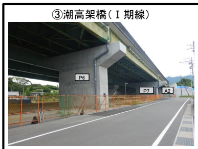
③潮高架橋 (I期線) P6・P7・A2橋台 拡幅 施工完了
