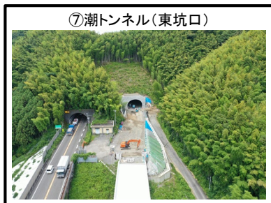
⑦潮トンネル (東坑口) 路床工 施工完了
