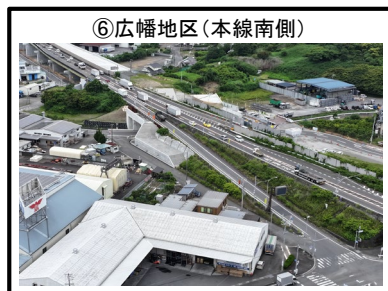
⑥広幡地区 (本線南側) 擁壁工 施工完了
