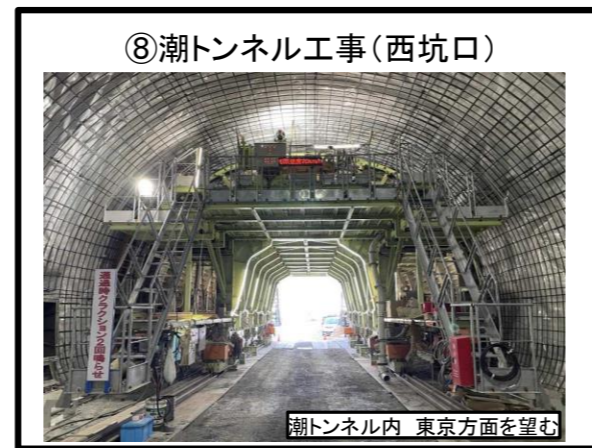
トンネル覆工 施工中
