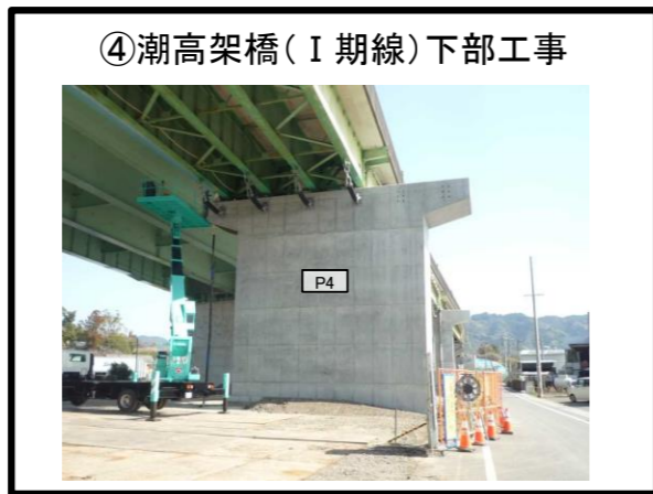
P4橋脚 拡幅 施工完了
