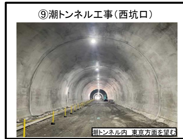
トンネル覆工 施工中
