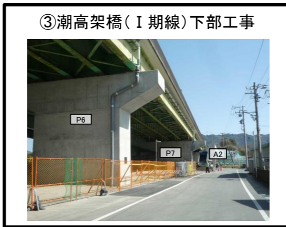
P6・P7・A2橋台 拡幅 施工完了
