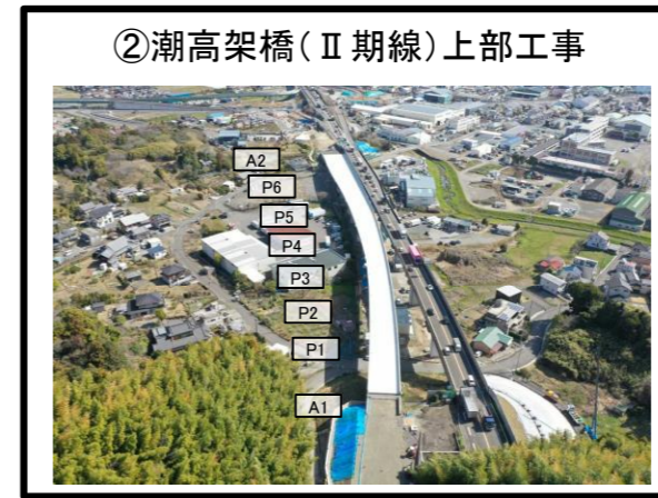
A1橋台～A2橋台 上部工 施工完了
