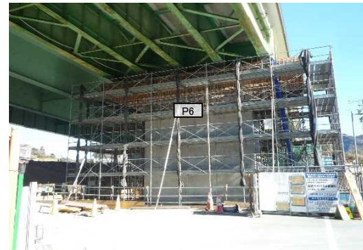
P6橋脚 拡幅 施工中
