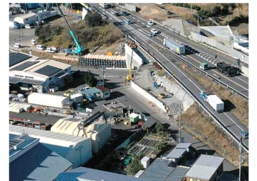
⑥広幡道路建設工事
