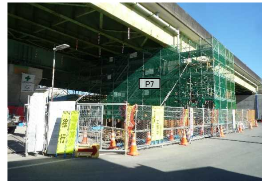
P7橋脚 拡幅 施工中
