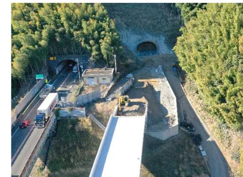
⑦潮トンネル工事（東坑口）
