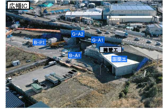
擁壁工 施工中
