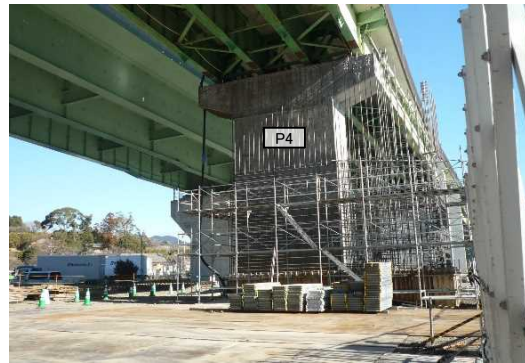
P4橋脚 拡幅 施工中
