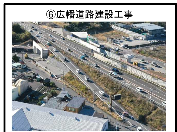
⑥広幡道路建設工事 擁壁工 施工中
