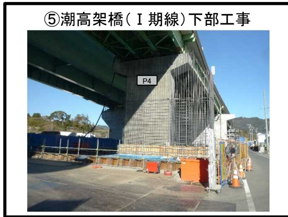
⑤潮高架橋（Ⅰ期線）下部工事 P4橋脚 拡幅 施工中
