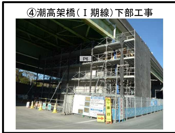
④潮高架橋（Ⅰ期線）下部工事 P6橋脚 拡幅 施工中
