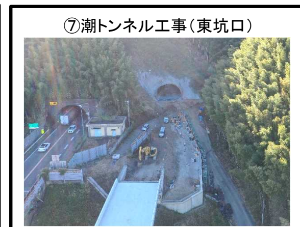
⑦潮トンネル工事（東坑口） 擁壁工 施工中
