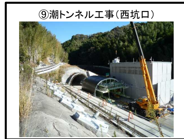
⑨潮トンネル工事（西坑口） トンネル覆工 準備中
