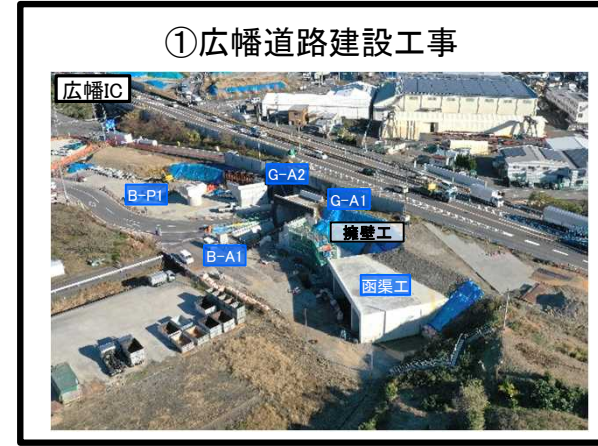
①広幡道路建設工事 擁壁工 施工中
