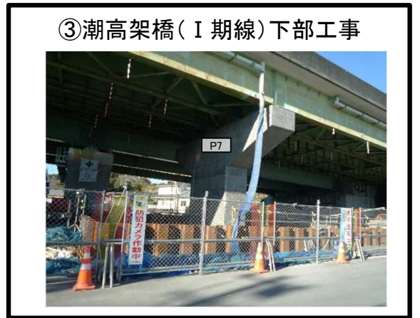
③潮高架橋（Ⅰ期線）下部工事 P7橋脚 拡幅 施工中
