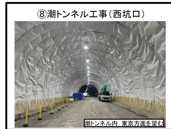
⑧潮トンネル工事（西坑口） トンネル防水工 施工中
