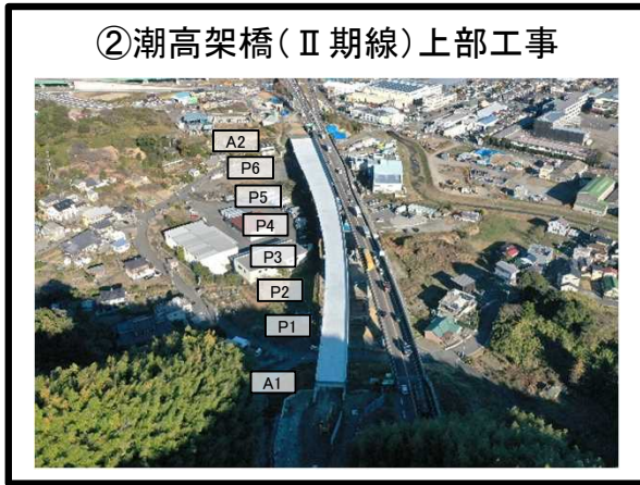
②潮高架橋（Ⅱ期線）上部工事 A1橋台～A2橋台 上部工 施工完了
