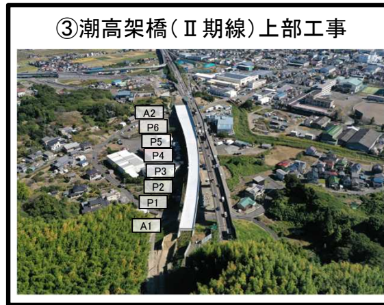
③潮高架橋（Ⅱ期線）上部工事 A1橋台～A2橋台 付属物工 施工中
