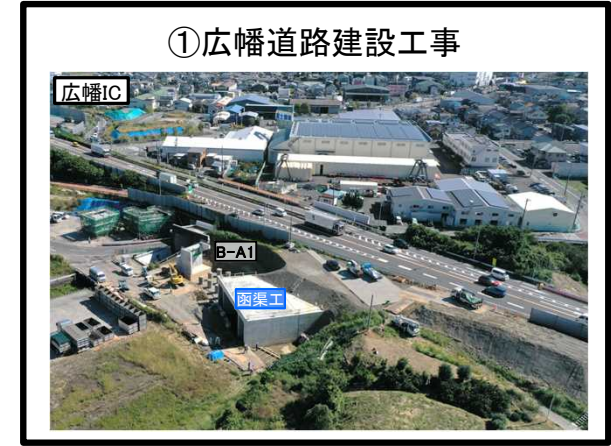
①広幡道路建設工事 天王町仮宿線 擁壁工 施工中
