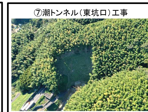
⑦潮トンネル（東坑口）工事 擁壁工 施工中
