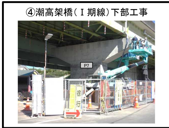
④潮高架橋（Ⅰ期線）下部工事 P7橋脚 拡幅 施工中
