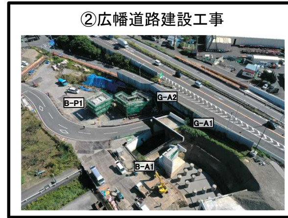
②広幡道路建設工事 広幡ICランプ橋 下部工 施工中
