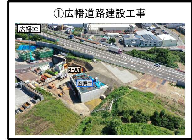
①広幡道路建設工事 天王町仮宿線 函渠工 施工完了
