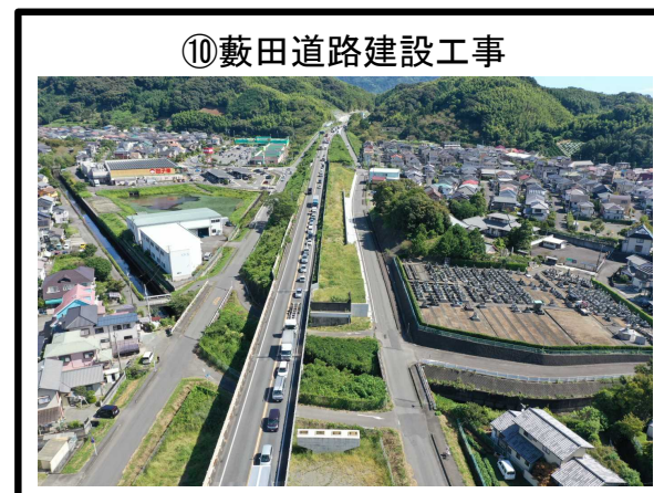
⑩藪田道路建設工事 擁壁工 施工完了
