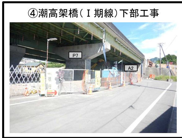
④潮高架橋（Ⅰ期線）下部工事 P7橋脚 下部工 増し杭 施工中
