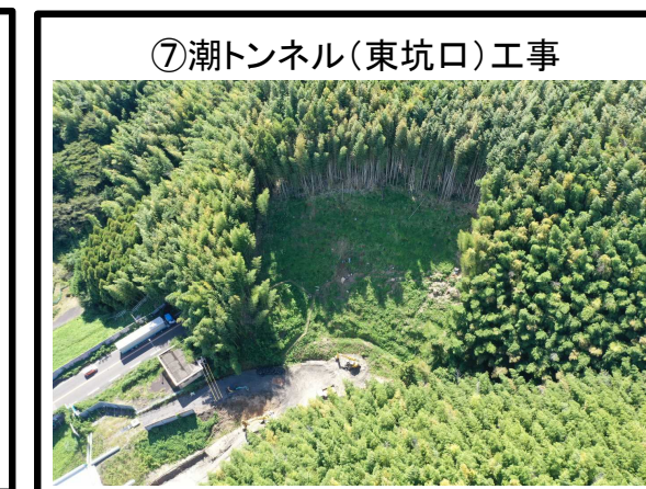
⑦潮トンネル（東坑口）工事 トンネル掘削工 施工中
