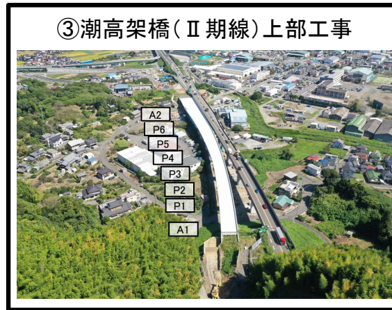
③潮高架橋（Ⅱ期線）上部工事 A1橋台～A2橋台 足場撤去 施工中
