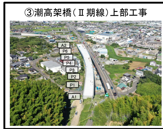
③潮高架橋（Ⅱ期線）上部工事 A1橋台～A2橋台 床版打設 施工中
