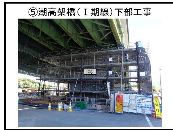
⑤潮高架橋（Ⅰ期線）下部工事 P6橋脚 拡幅 施工中
