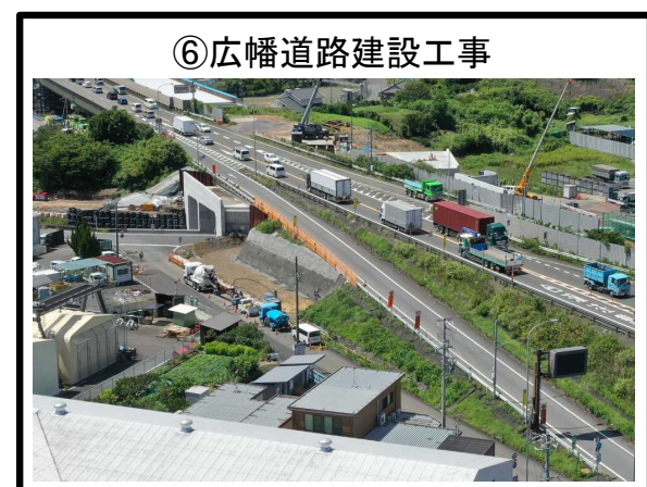
⑥広幡道路建設工事 7-2号擁壁 施工中
