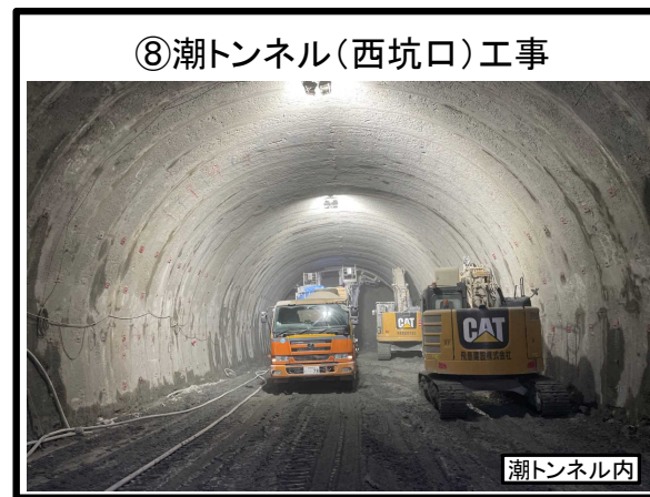
⑧潮トンネル（西坑口）工事 トンネル掘削工 施工中
