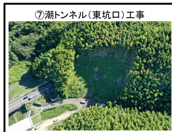
⑦潮トンネル（東坑口）工事 トンネル掘削工 施工中
