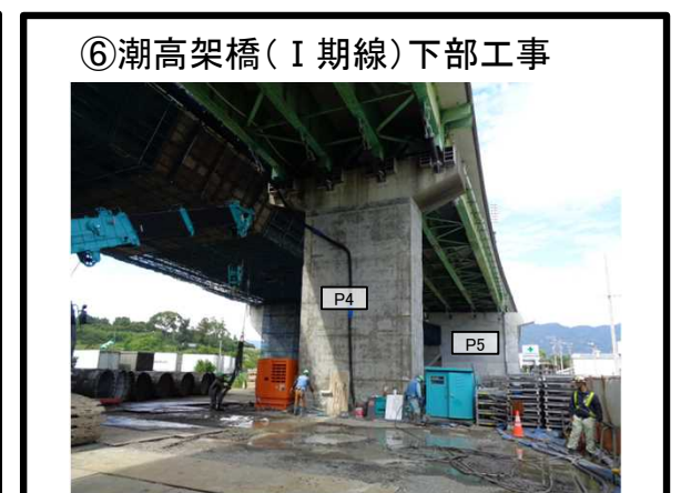
⑥潮高架橋（Ⅰ期線）下部工事 P4橋脚 増し杭 施工中
