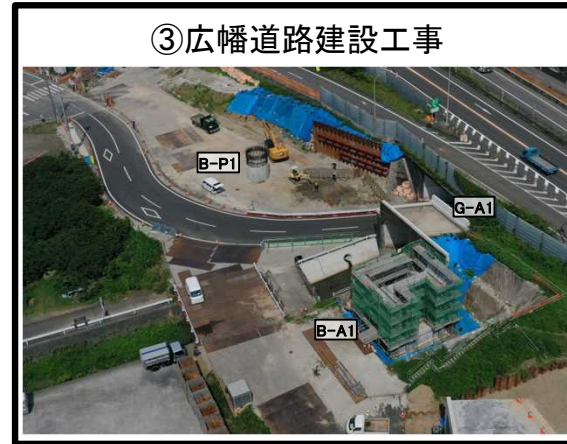
③広幡道路建設工事 広幡ICランプ橋 下部工 施工中
