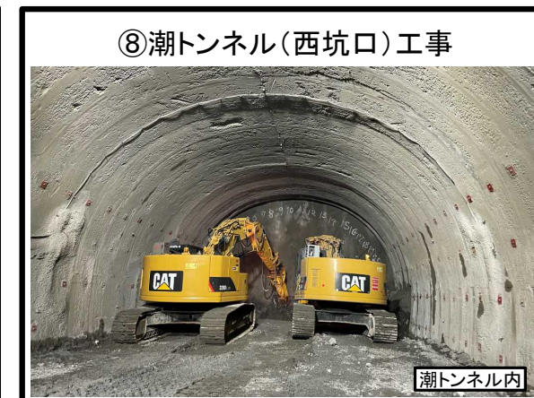
⑧潮トンネル（西坑口）工事 トンネル掘削工 施工中
