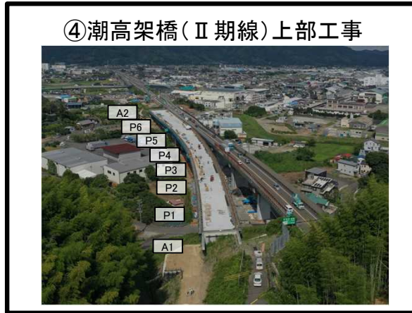
④潮高架橋（Ⅱ期線）上部工事 A1橋台～A2橋台 床版打設 施工中
