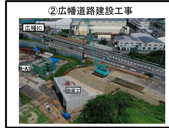
②広幡道路建設工事 天王町仮宿線 函渠工 施工中
