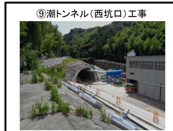
⑨潮トンネル（西坑口）工事 トンネル掘削工 施工中
