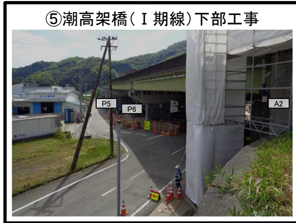
⑤潮高架橋（Ⅰ期線）下部工事 P6橋脚 下部工 拡幅 施工中
