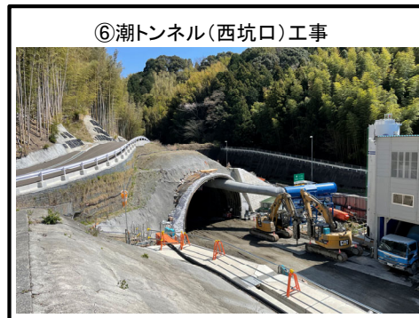
トンネル掘削工 施工中
