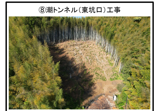
トンネル工 施工中
