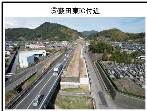
擁壁工 施工完了
