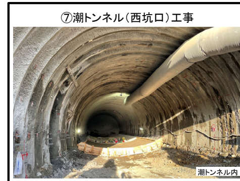
トンネル掘削工 施工中
