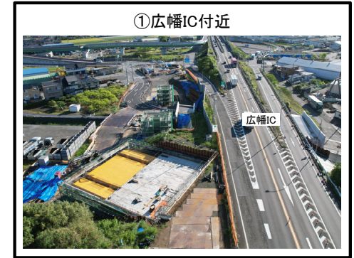
広幡ICランプ橋 拡幅 施工中
