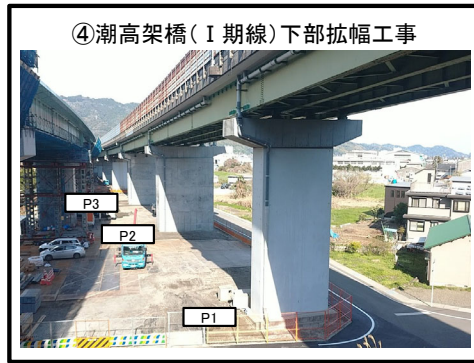
P1～P3,P5橋脚 下部工拡幅 施工完了
