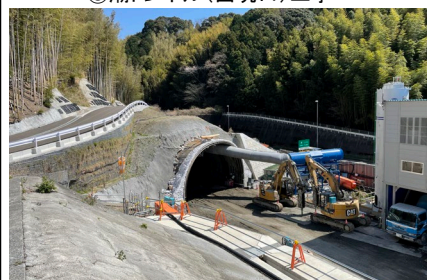
⑥潮トンネル(西坑口)工事
