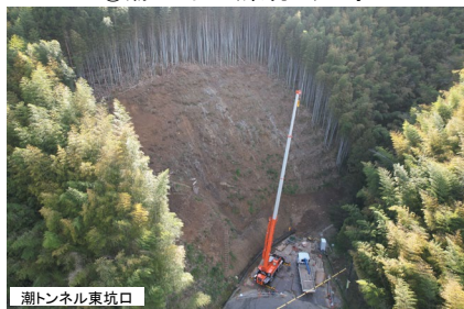
④潮トンネル(東坑口)工事
