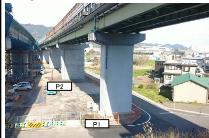
③潮高架橋(Ⅰ期線)下部工拡幅工事
