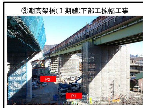
P1～P2橋脚 下部工拡幅 施工中
