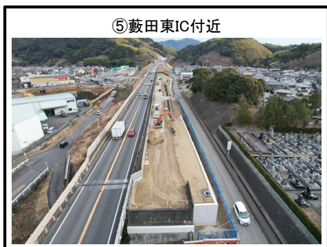
擁壁工 施工中
