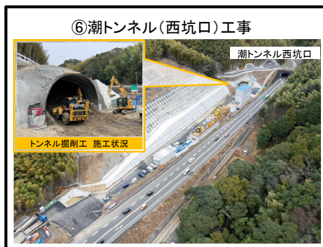
トンネル工 施工中
