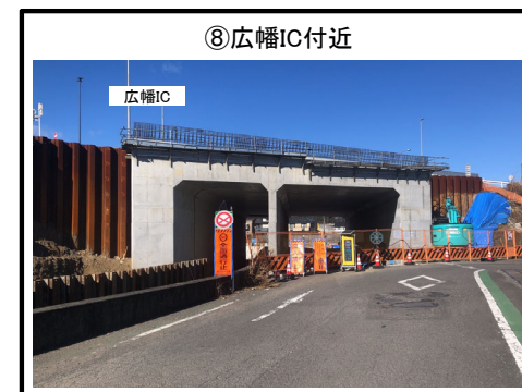
広幡ICランプ橋 拡幅 施工中
