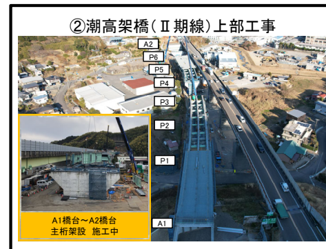
A1橋台～A2橋台 主桁架設 施工中
