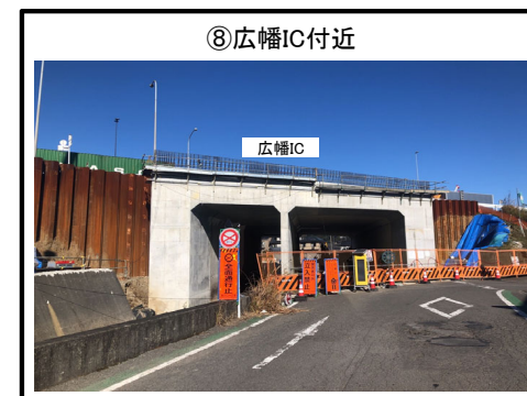
広幡ICランプ橋 拡幅 施工中
