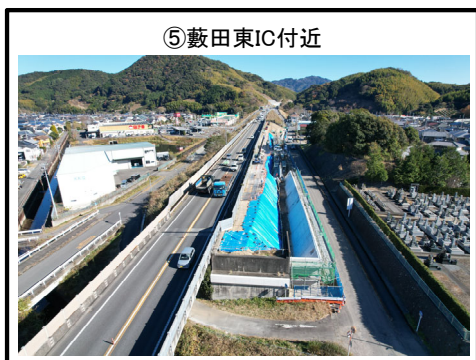
擁壁工 施工中
