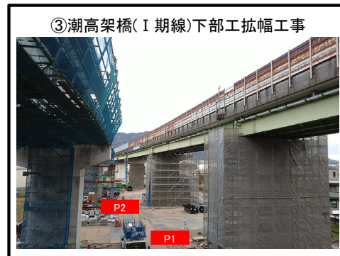
P1～P2橋脚 下部工拡幅 施工中
