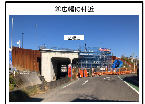
広幡ICランプ橋 拡幅 施工中
