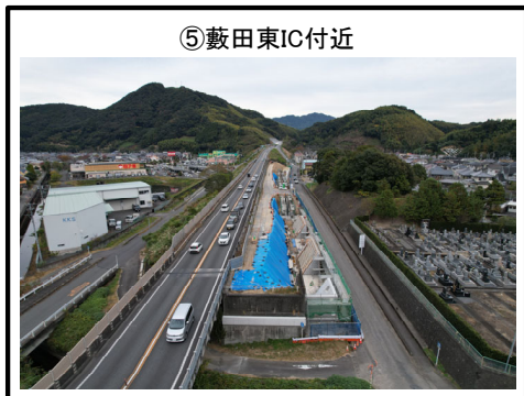
擁壁工 施工中
