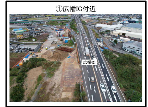
広幡ICランプ橋 拡幅 施工中
