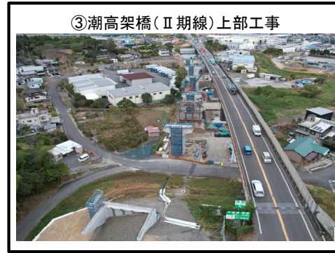
A1橋台～A2橋台 主桁架設 施工準備中
