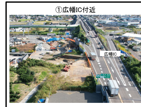
広幡ICランプ橋 拡幅 施工中
