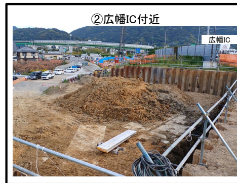
天王町仮宿線 施工中
