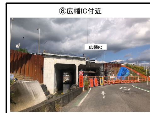
広幡ICランプ橋 拡幅 施工中
