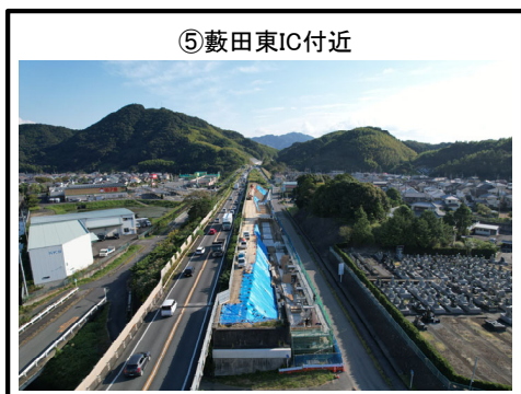
擁壁工 施工中
