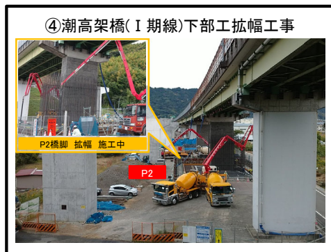
P2橋脚 下部工拡幅 施工中
