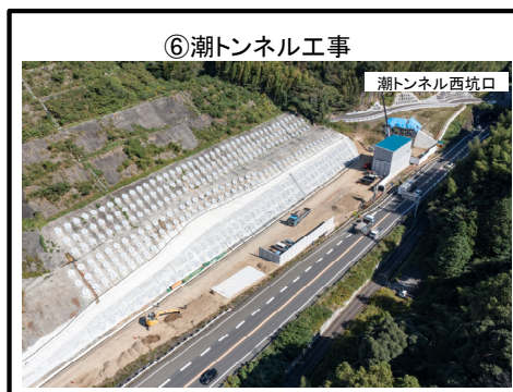
トンネル工 施工準備中
