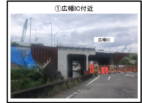
広幡ICランプ橋 拡幅 施工中
