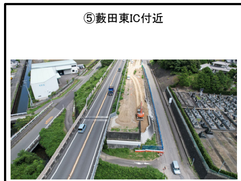
擁壁工 施工準備中
