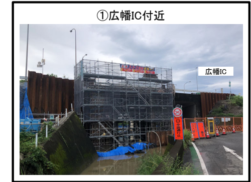
広幡ICランプ橋 拡幅 施工中
