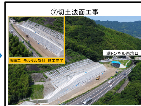
法面工 モルタル吹付 施工完了
