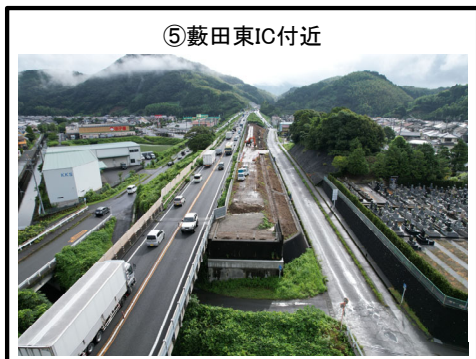
擁壁工 施工準備中
