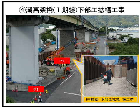
P1橋脚 P2橋脚 下部工拡幅 施工中
