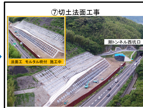
法面工 モルタル吹付 施工中
