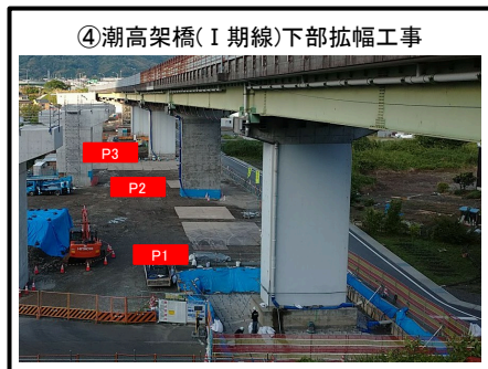
P1橋脚 下部拡幅 施工中
