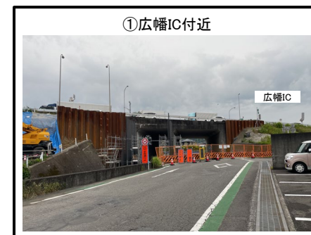
広幡ICランプ橋 拡幅 施工中
