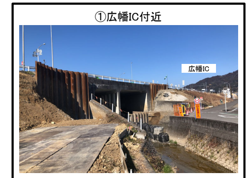
広幡ICランプ橋拡幅の施工中
