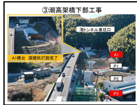
A1橋台 深礎杭工の打設完了
