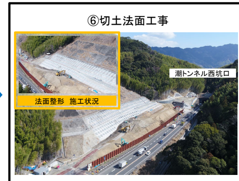
法面整形工 施工中
