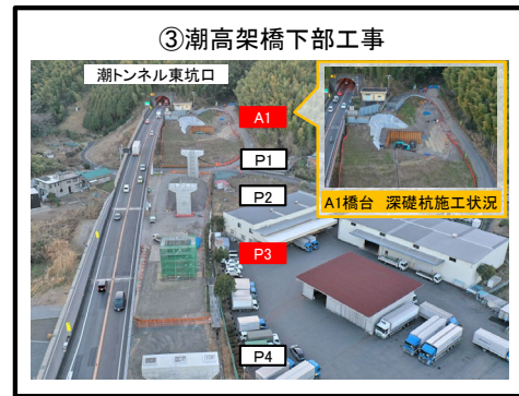
A1橋台 深礎杭工の施工中
