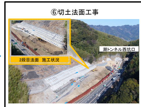
法面工 2段階施工中
