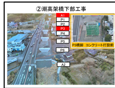
P3橋脚 柱部のコンクリート打設準備
