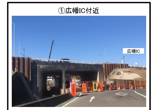
広幡ICランプ橋拡幅の施工中
