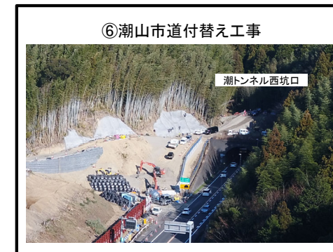
地盤改良工 施工中
