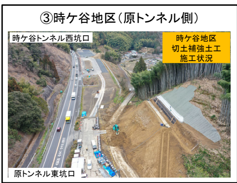
切土補強土工 施工中
