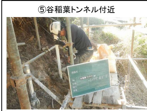
水位観測孔 珪砂充填状況
