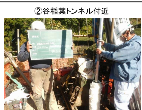
孔内傾斜計挿入状況
