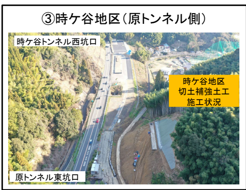
切土補強土工に着手
