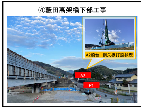
A2橋台 鋼矢板打設に着手
