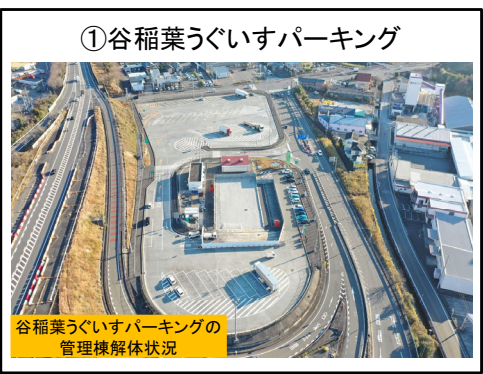
管理棟解体完了
