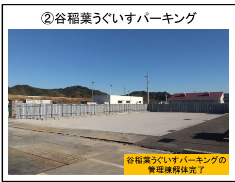
管理棟解体完了
