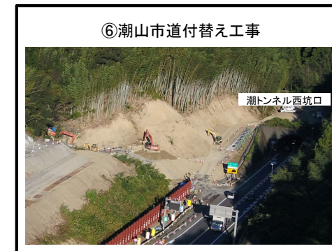
地盤改良工 施工中
