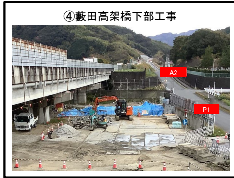
P1橋脚 掘削、杭頭処理完了
