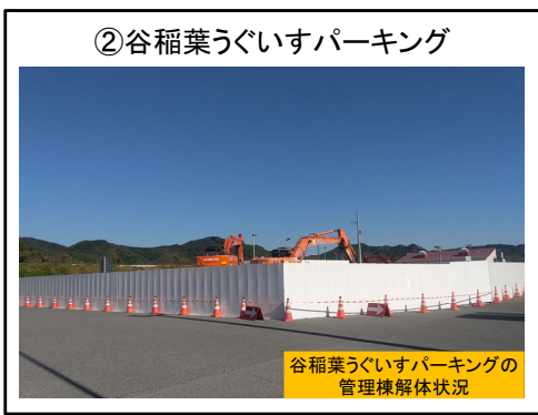
管理棟解体施工中
