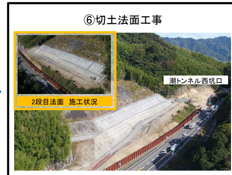
法面工 2段目施工中
