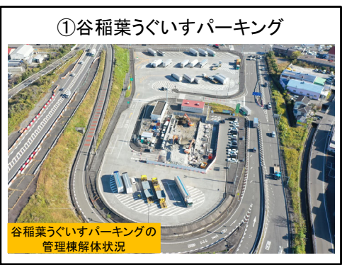
管理棟解体施工中
