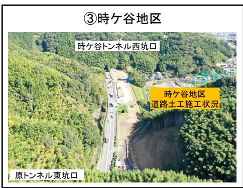
道路土工施工中
