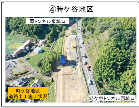
道路土工施工中
