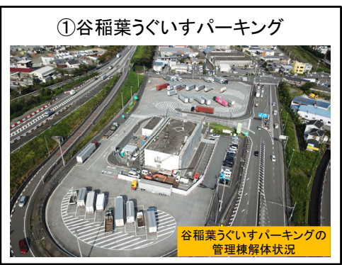
管理棟解体に着手
