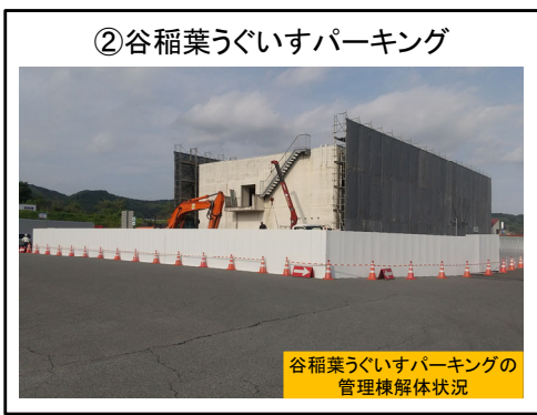
管理棟解体に着手
