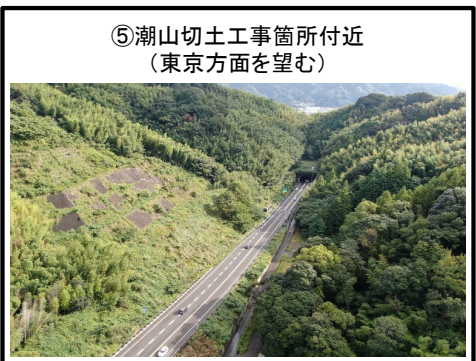
⑤潮山切土工事箇所付近 (東京方面を望む) 着手前
