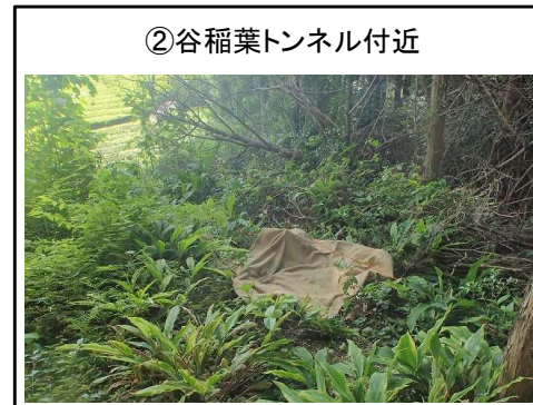
弾性波探査 探査時飛散対策実施状況
