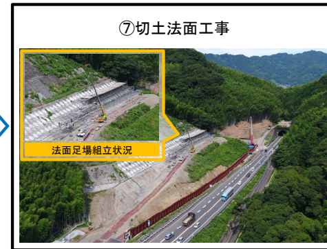
⑦切土法面工事 アンカー打設のため、法面足場組立に着手
