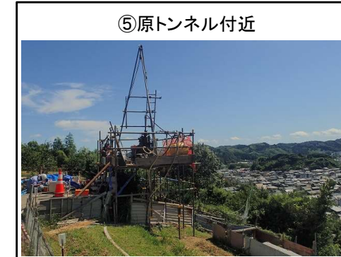
鉛直ボーリング実施状況
