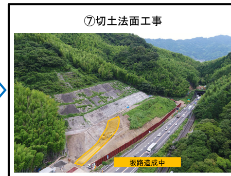
アンカー打設のため、坂路造成中
