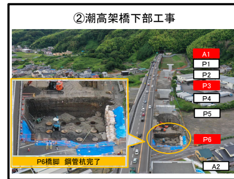
P6橋脚 鋼管杭の打設完了
