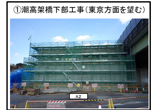
A2橋台の梁部型枠組立中
