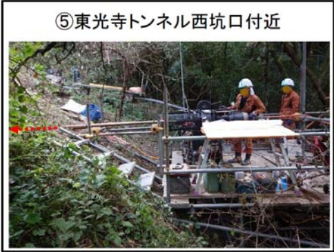
水平ボーリング実施状況
