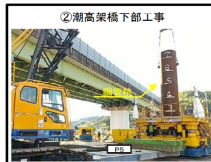
P5橋脚の鋼管杭施工状況
