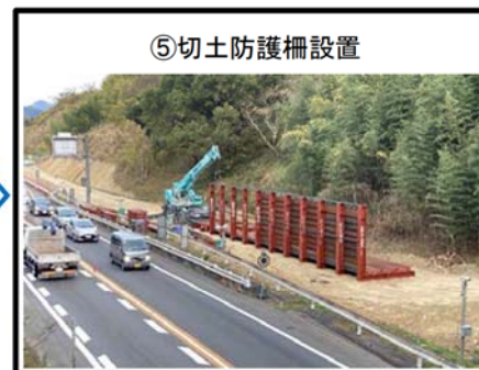
12月上旬～ 施工中
