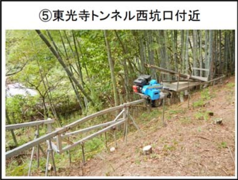
モノレール設置状況
