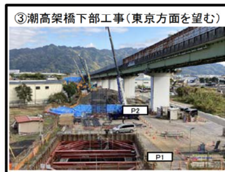
P1橋脚・P2橋脚の施工状況
