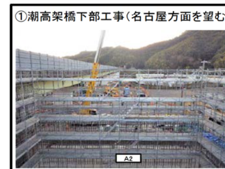
A2橋台 足場設置状況
