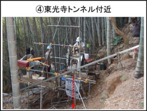
鉛直ボーリング実施状況
