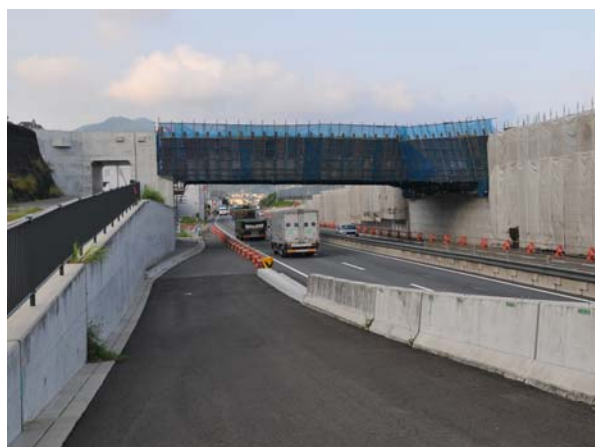
上部工架設完了 (H25. 8)
