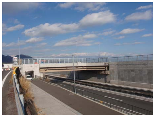
上部工完成 (H26. 1)
