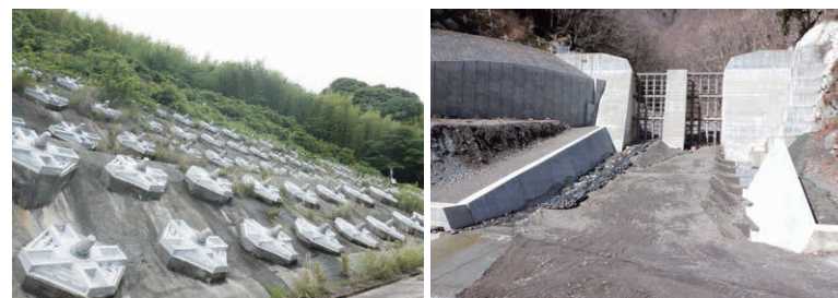
地盤アンカー
