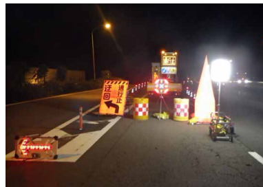
集中工事による通行止めの様子
