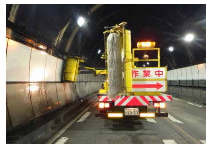
トンネル壁面の清掃
