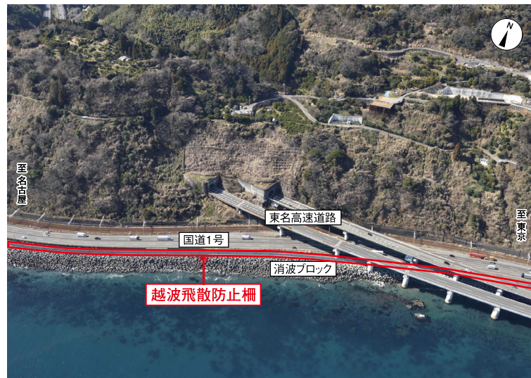
国道1号富士由比バイパス越波飛散防止柵の設置状況
