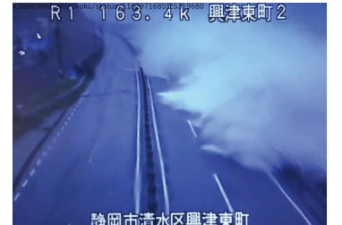
越波発生時(令和元年:台風19号)
