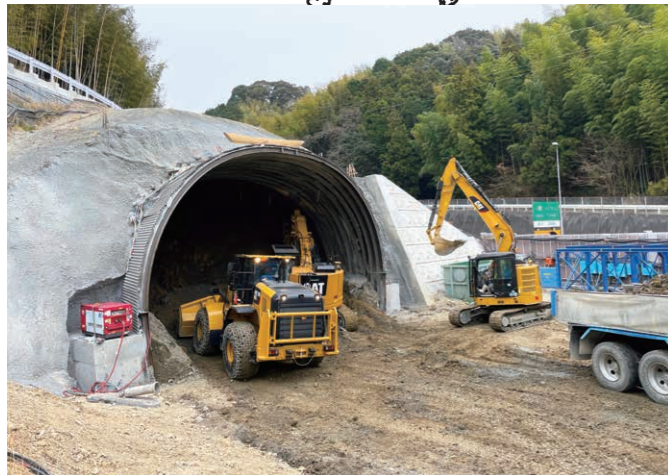
トンネルを掘る工事の状況
