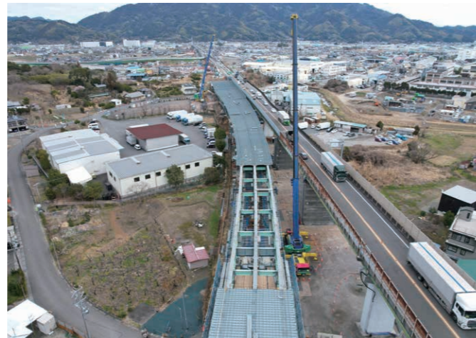
橋を架ける工事の状況
