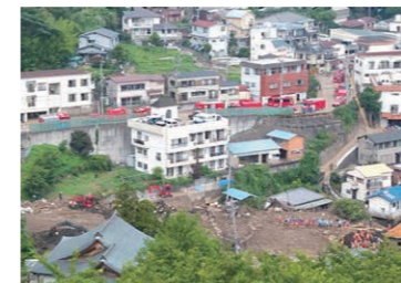
ドローンによる現地調査
