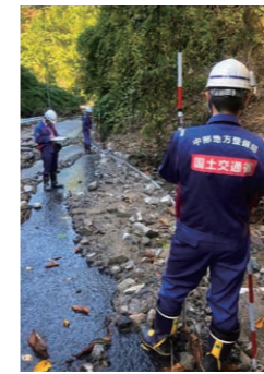
のり面崩壊部の調査
