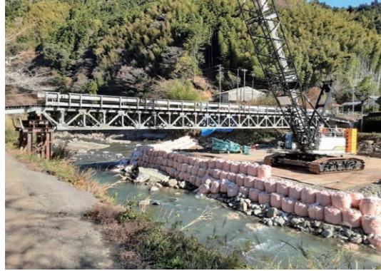
③ 応急的に組立橋を施工
