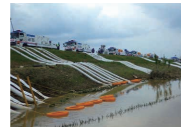
排水ポンプ車による浸水地域での汲み上げ作業状況
