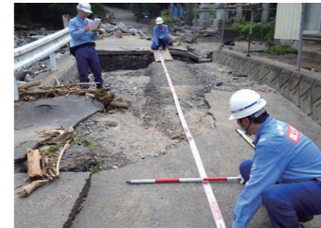
道路損傷部の調査
