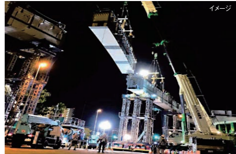
ベント(仮設の柱)を用いたクレーン架設
