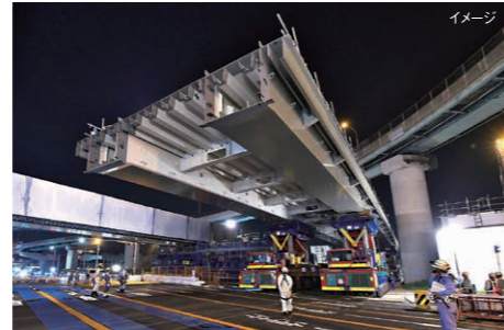
多軸式台車による架設
