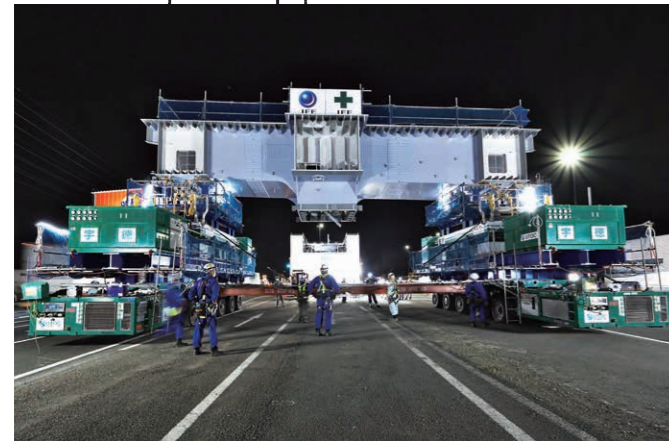
清水インター西交差点付近橋脚横梁架設状況
